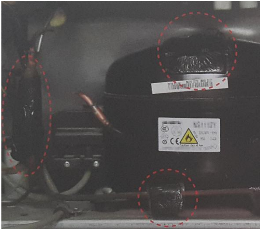
[ 그림.3 압축기 및 배관설치 예 ]
